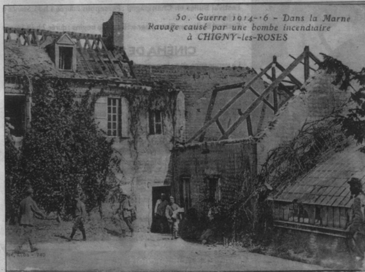
A Chigny-les-Roses, une maison détruite par un bombardement aérien.
